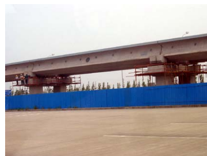
施工中的上海磁浮列車，孔憲法 攝
