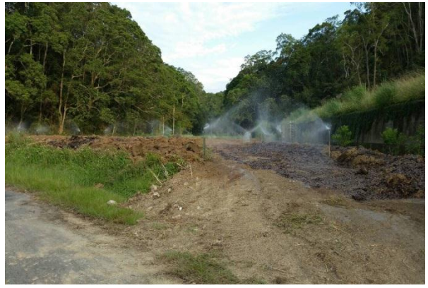
覆土推肥、灑水破壞 4
