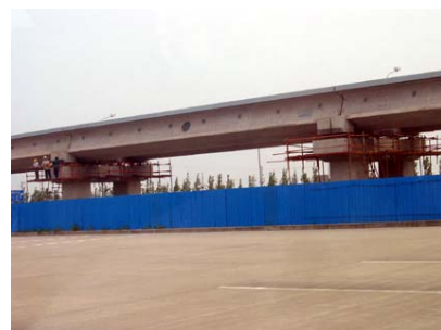
施工中的上海磁浮列車，孔憲法 攝
